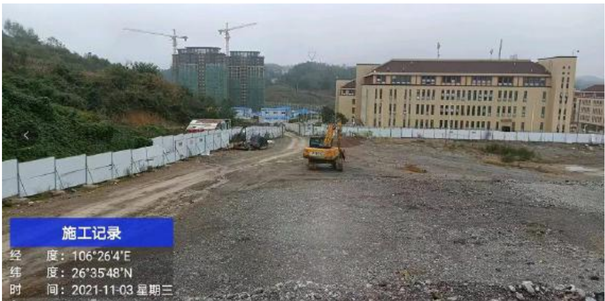
图 4-5 调查地块内部（北侧）现场踏勘图
