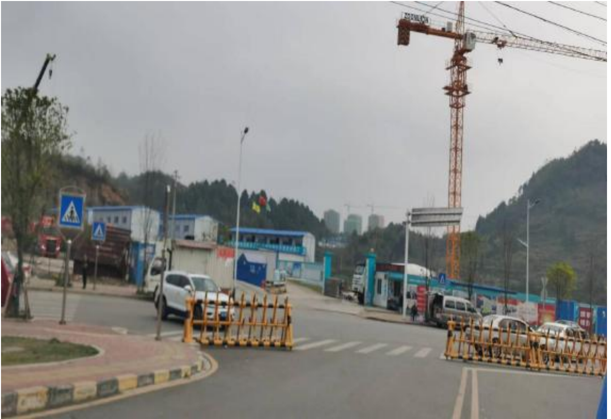
图 4-10 地块东侧地块开发建设清镇市保障房现场踏勘图（2022 年 11 月）
