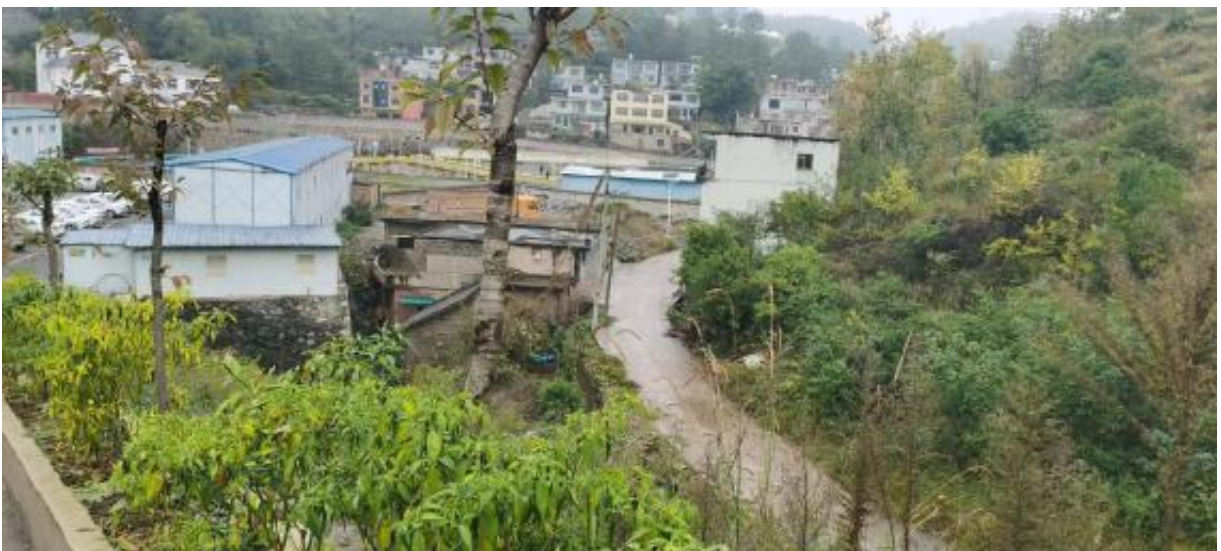
图 4-7 地块周边东侧赵五寨村（燕尾村）现场踏勘图
